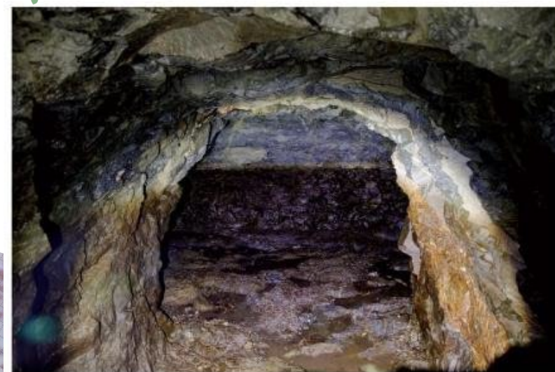
VANNLÅGER: Slik ser høydebassenget ut fra inngangen. Det er formet som en T, så det er ikke mulig å se hele bassenget fra denne vinkelen. Foto: Paul St. Arntsen/NTNU, VG
