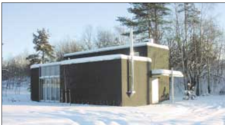
Ny kombinert avløpspumpestasjon og reduksjonskum på Fornebu. Anlegget ble befart under seminaret for driftspersonell.
